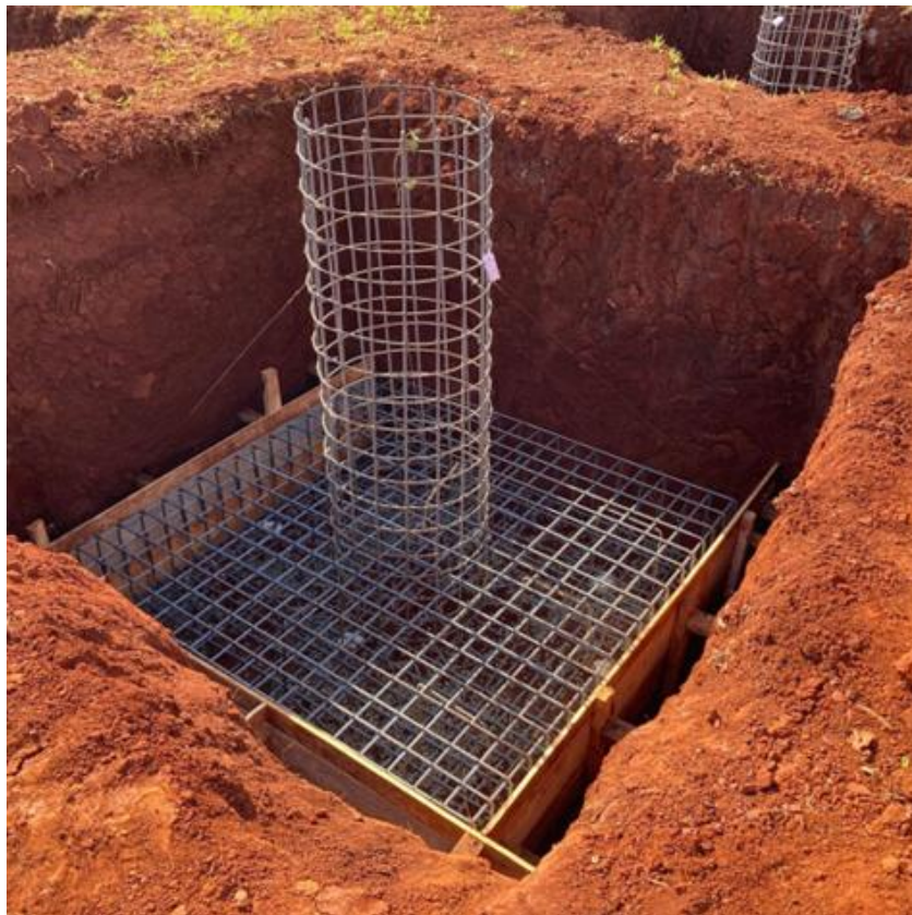
Figura 4: Zapata Aislada de Cimentación Superficial
