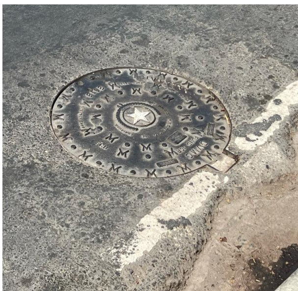
Figura 70. Tapa de Cámara de Inspección A51
