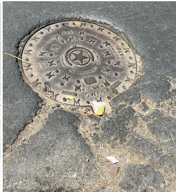
Figura 43. Tapa de Cámara de Inspección A24
