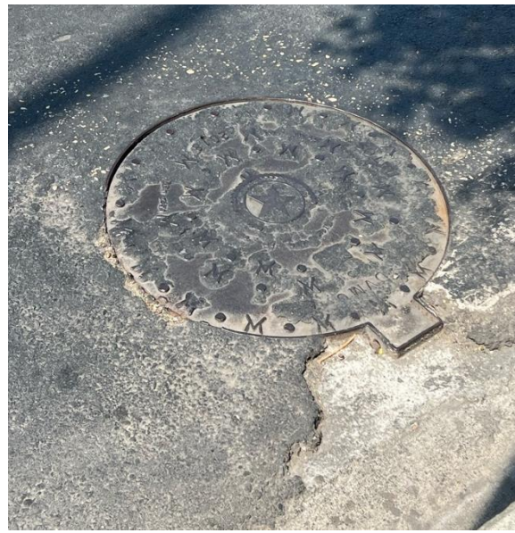
Figura 41. Tapa de Cámara de Inspección A22
