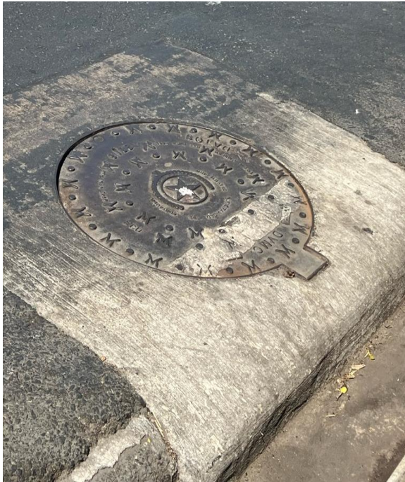
Figura 52. Tapa de Cámara de Inspección A33
