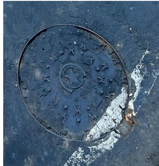
Figura 25. Tapa de Cámara de Inspección A6
