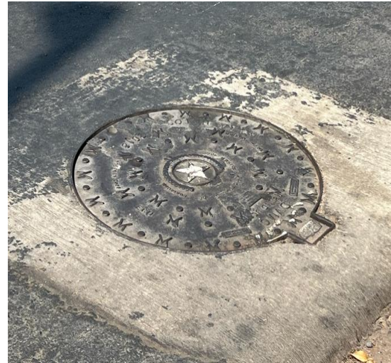
Figura 65. Tapa de Cámara de Inspección A46
