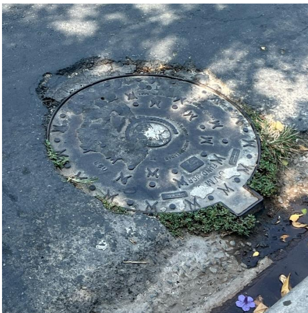
Figura 74. Tapa de Cámara de Inspección A55
