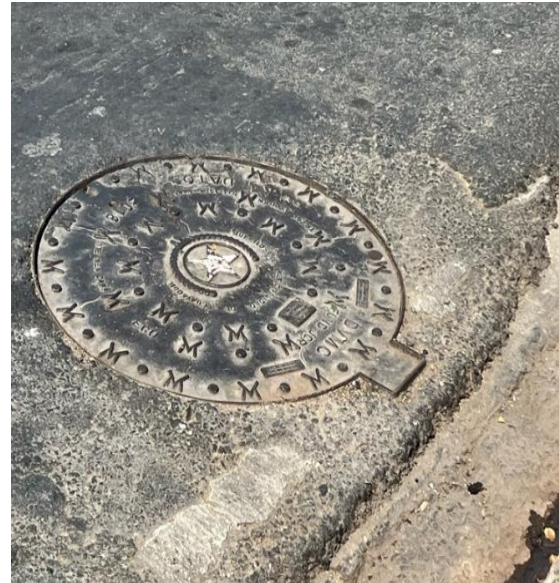
Figura 73. Tapa de Cámara de Inspección A54
