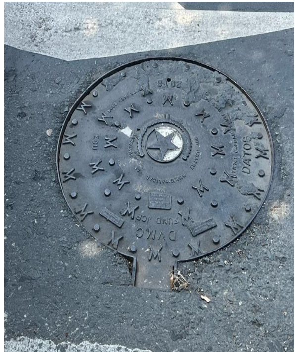
Figura 31. Tapa de Cámara de Inspección A12
