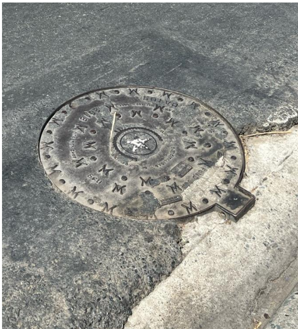
Figura 46. Tapa de Cámara de Inspección A27
