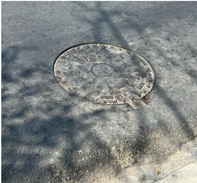
Figura 24. Tapa de Cámara de Inspección A5
