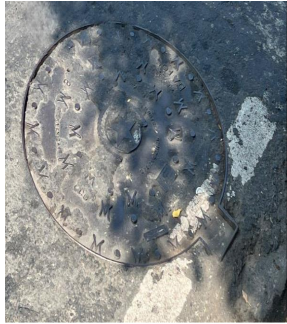
Figura 29. Tapa de Cámara de Inspección A10
