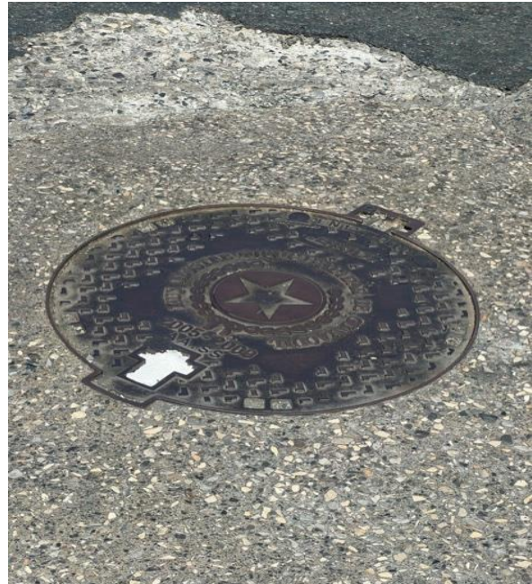
Figura 21. Tapa de Cámara de Inspección A2
