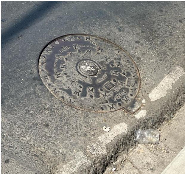
Figura 54. Tapa de Cámara de Inspección A35
