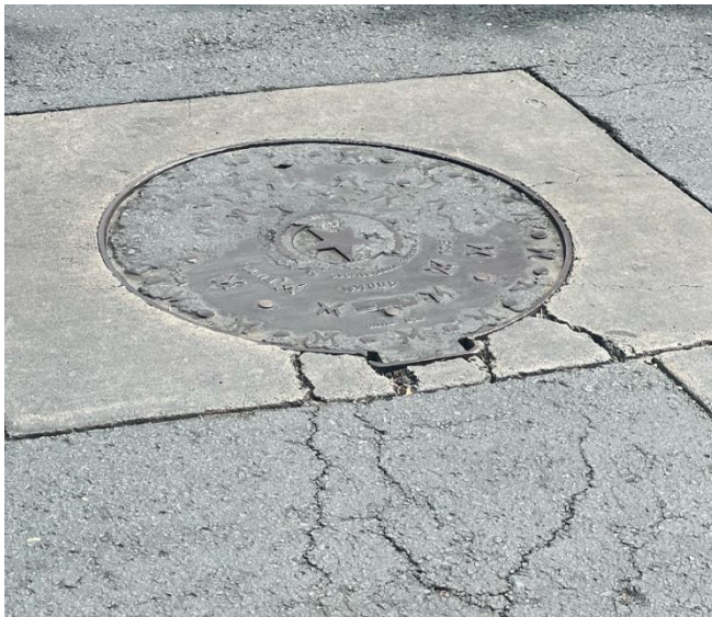
Figura 100. Tapa de Cámara de Inspección B15
