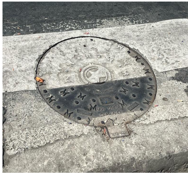
Figura 57. Tapa de Cámara de Inspección A38
