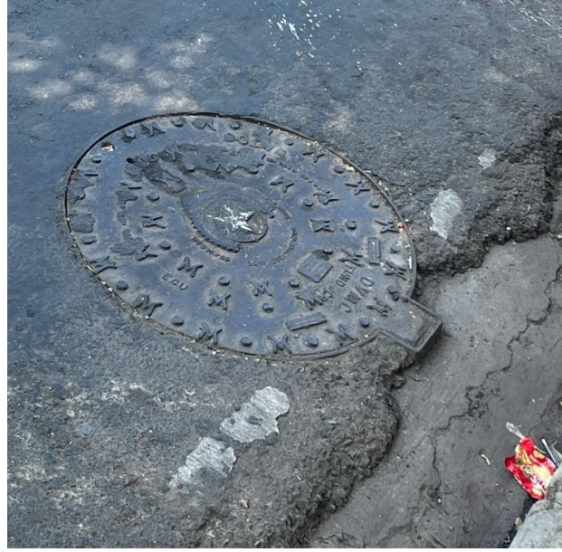
Figura 45. Tapa de Cámara de Inspección A26
