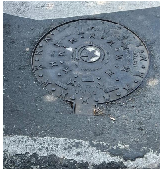
Figura 61. Tapa de Cámara de Inspección A42
