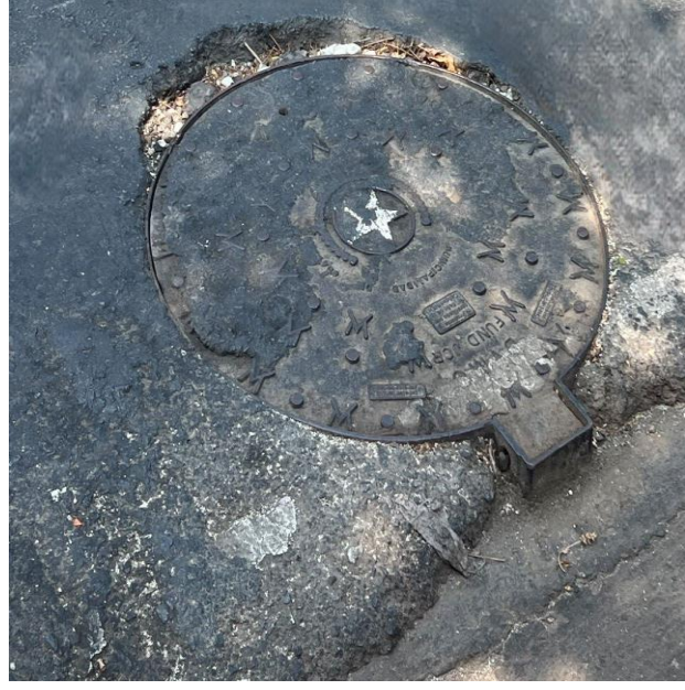
Figura 77. Tapa de Cámara de Inspección A58
