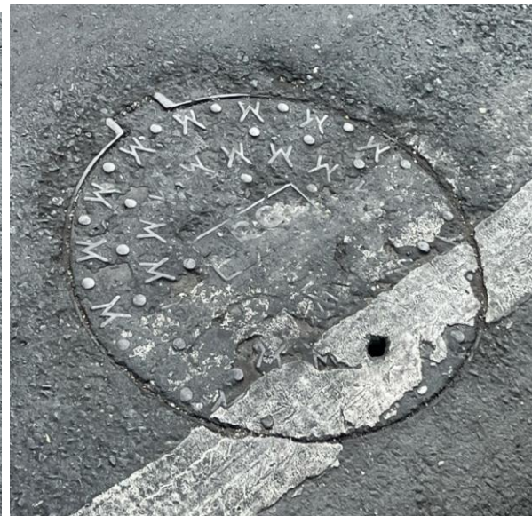
Figura 91. Tapa de Cámara de Inspección B6
