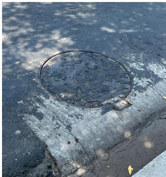
Figura 69. Tapa de Cámara de Inspección A50
