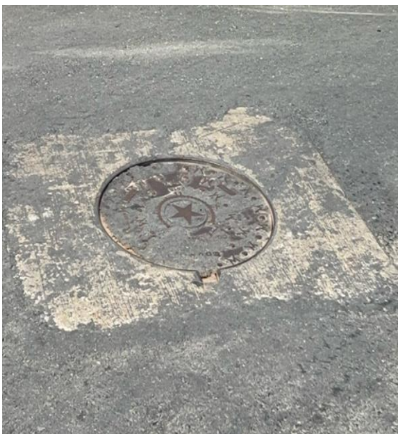
Figura 34. Tapa de Cámara de Inspección A15
