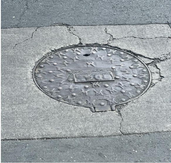
Figura 84. Tapa de Cámara de Inspección A65
