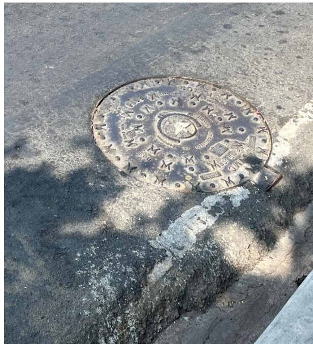
Figura 53. Tapa de Cámara de Inspección A34
