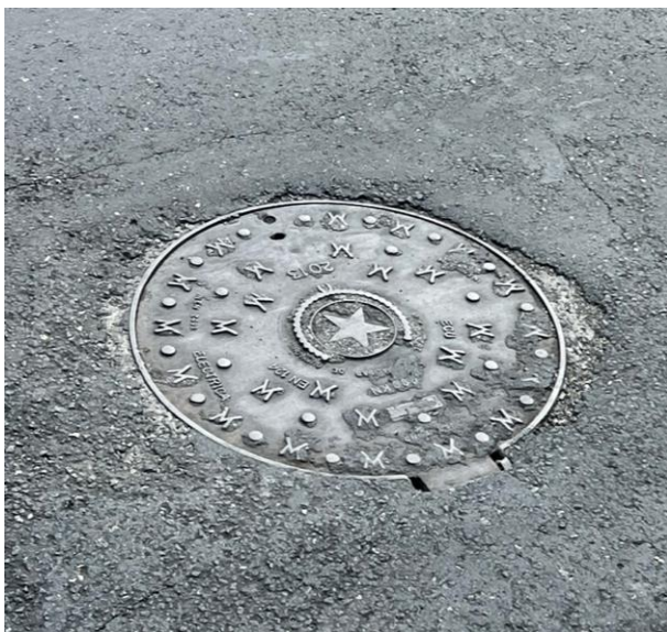
Figura 90. Tapa de Cámara de Inspección B5
