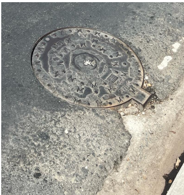
Figura 78. Tapa de Cámara de Inspección A59
