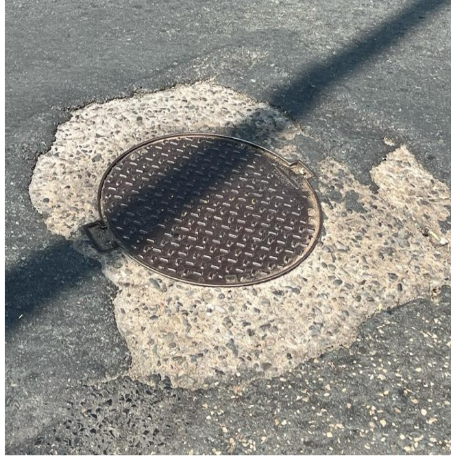
Figura 33. Tapa de Cámara de Inspección A14
