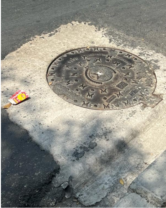
Figura 32. Tapa de Cámara de Inspección A13
