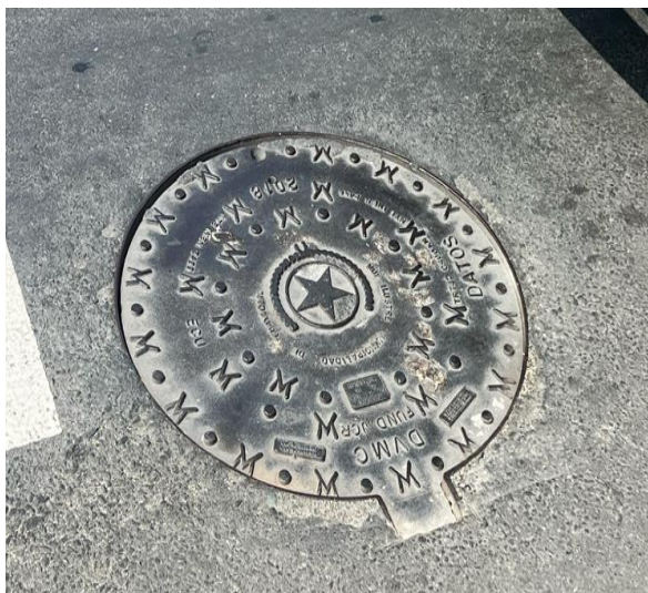
Figura 22. Tapa de Cámara de Inspección A3
