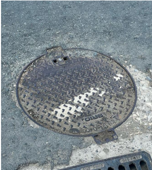
Figura 20. Tapa de Cámara de Inspección A1
