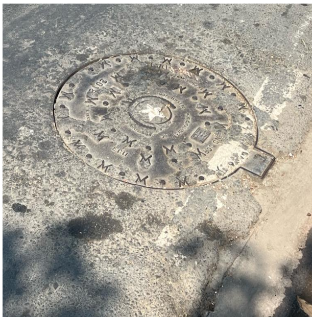
Figura 68. Tapa de Cámara de Inspección A49
