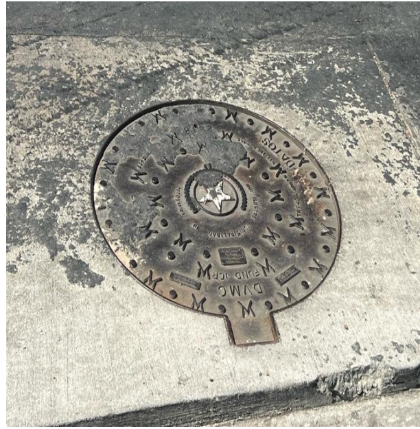
Figura 35. Tapa de Cámara de Inspección A16
