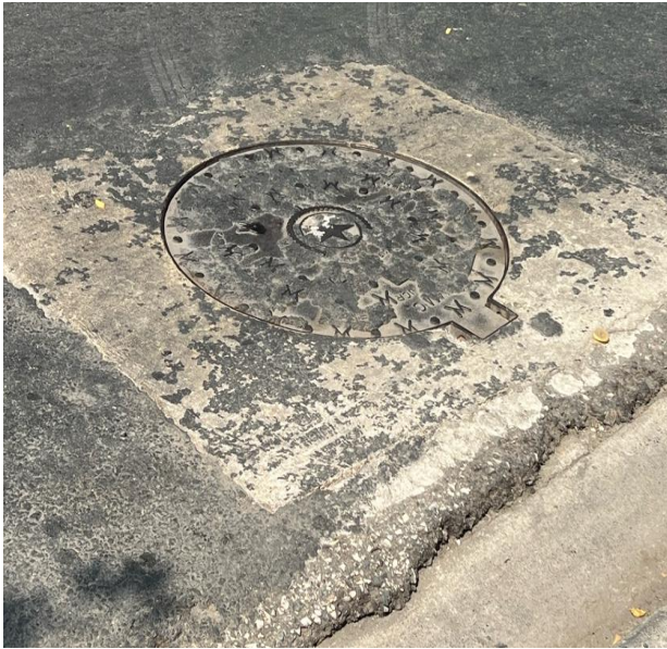
Figura 40. Tapa de Cámara de Inspección A21
