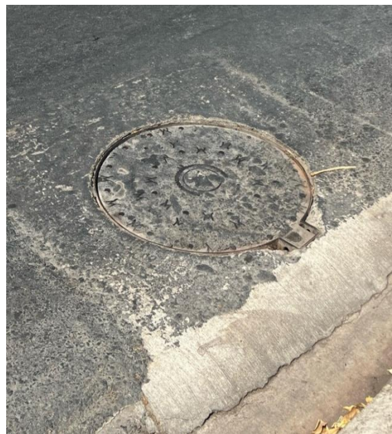
Figura 79. Tapa de Cámara de Inspección A60
