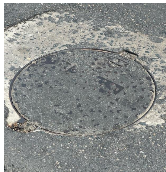
Figura 103. Tapa de Cámara de Inspección B18
