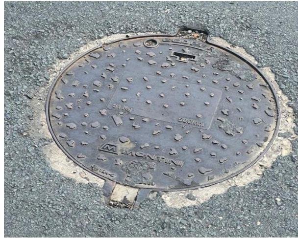
Figura 85. Tapa de Cámara de Inspección A66
