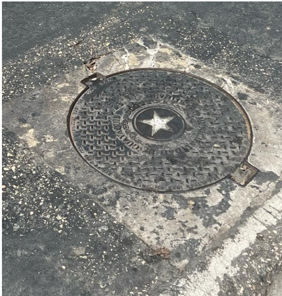
Figura 44. Tapa de Cámara de Inspección A25
