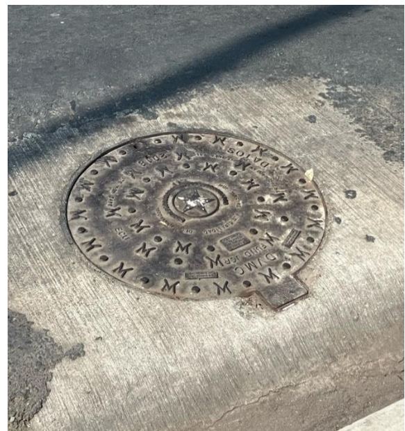
Figura 75. Tapa de Cámara de Inspección A56
