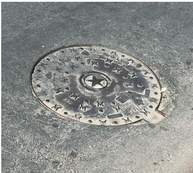
Figura 26. Tapa de Cámara de Inspección A7
