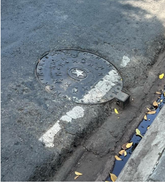
Figura 76. Tapa de Cámara de Inspección A57
