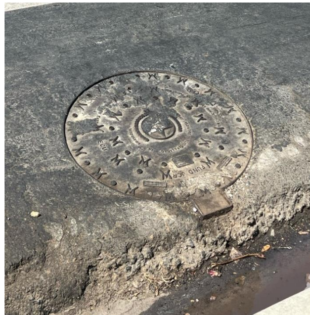
Figura 51. Tapa de Cámara de Inspección A32
