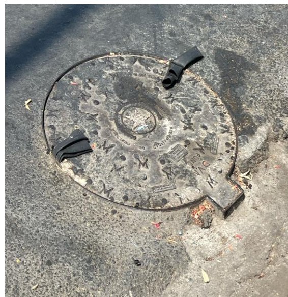
Figura 55. Tapa de Cámara de Inspección A36
