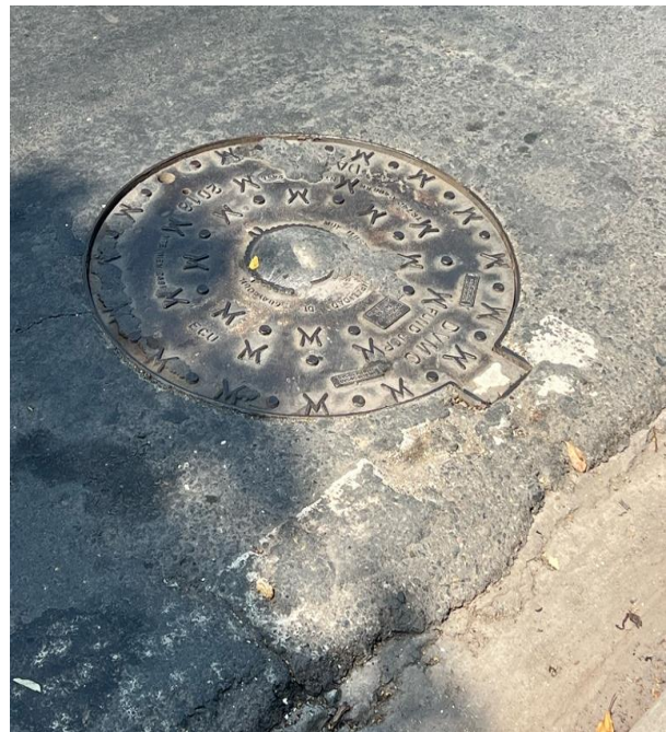
Figura 67. Tapa de Cámara de Inspección A48
