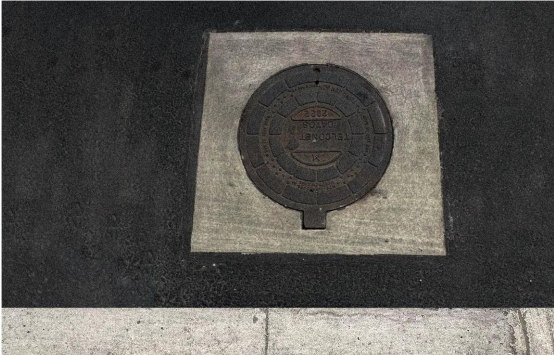
Figura 107. Nivelación de cota de carpeta asfáltica con cota de losa superior
