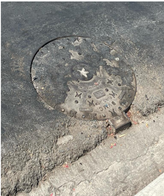
Figura 58. Tapa de Cámara de Inspección A39
