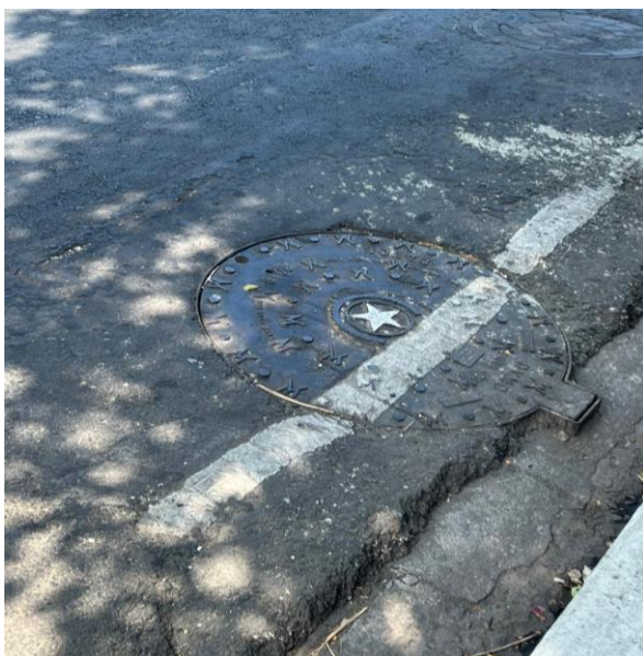
Figura 62. Tapa de Cámara de Inspección A43
