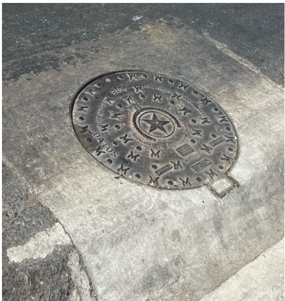
Figura 50. Tapa de Cámara de Inspección A31
