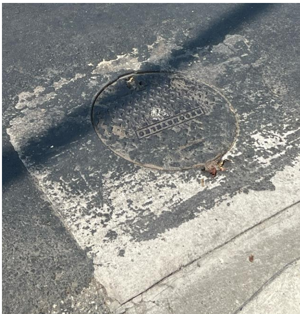
Figura 42. Tapa de Cámara de Inspección A23
