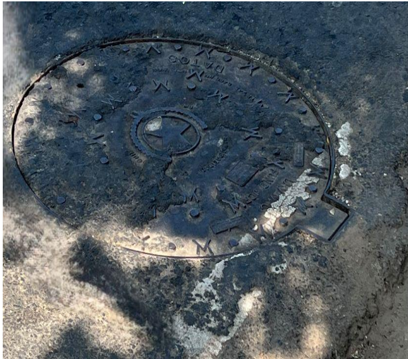
Figura 64. Tapa de Cámara de Inspección A45
