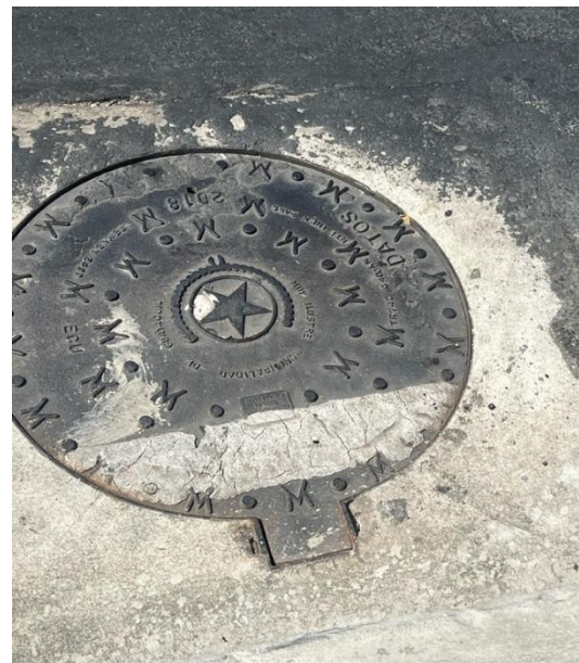
Figura 27. Tapa de Cámara de Inspección A8
