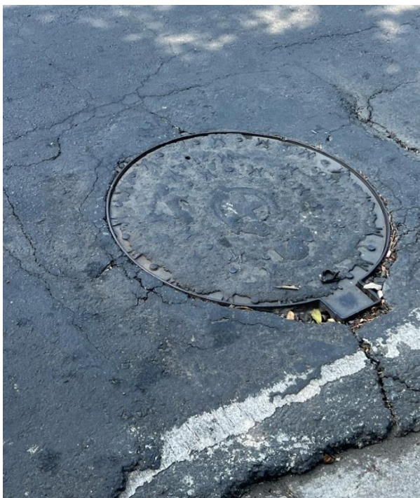
Figura 30. Tapa de Cámara de Inspección A11
