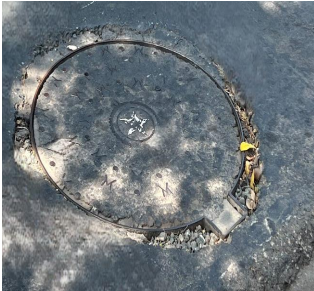
Figura 72. Tapa de Cámara de Inspección A53
