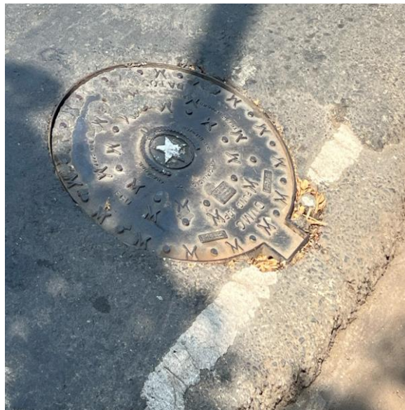
Figura 71. Tapa de Cámara de Inspección A52
