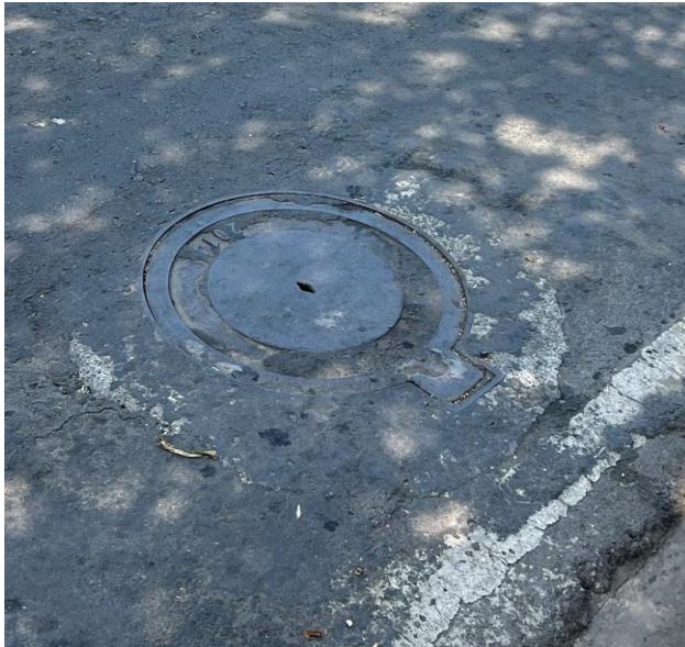
Figura 60. Tapa de Cámara de Inspección A41
