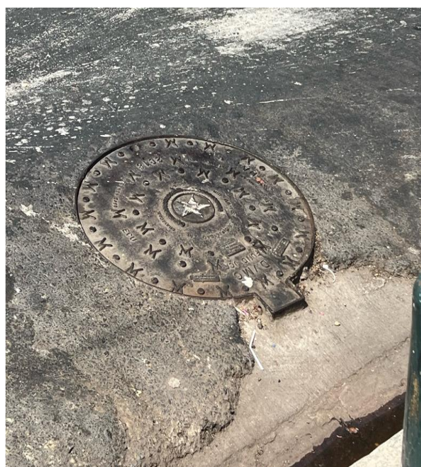
Figura 59. Tapa de Cámara de Inspección A40
