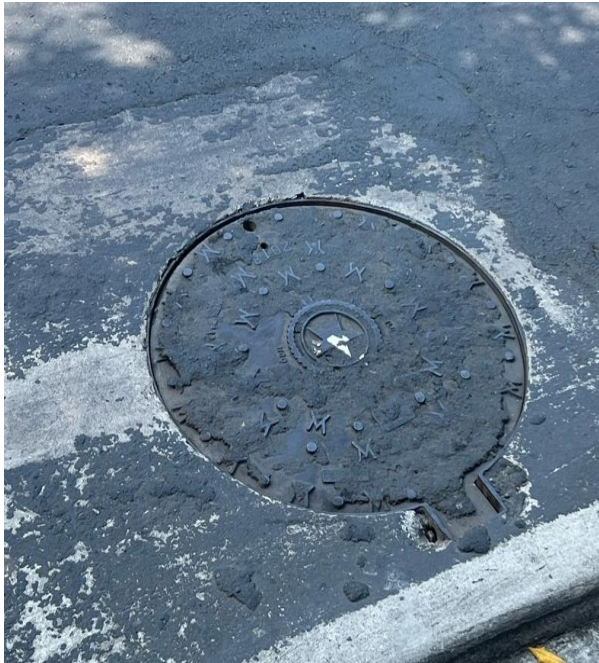
Figura 28. Tapa de Cámara de Inspección A9
