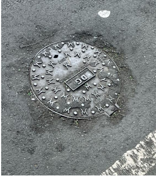
Figura 88. Tapa de Cámara de Inspección B3
