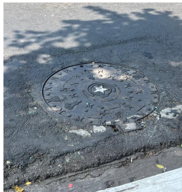
Figura 63. Tapa de Cámara de Inspección A44
