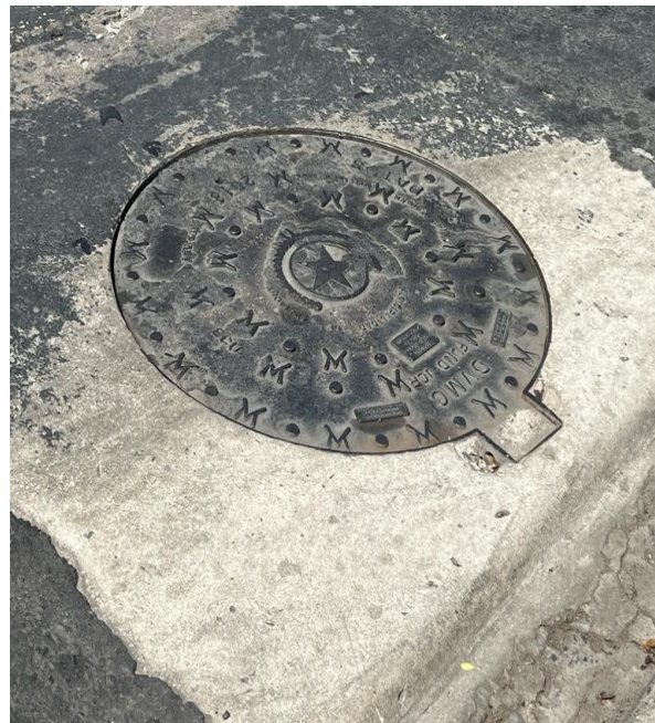
Figura 47. Tapa de Cámara de Inspección A28
