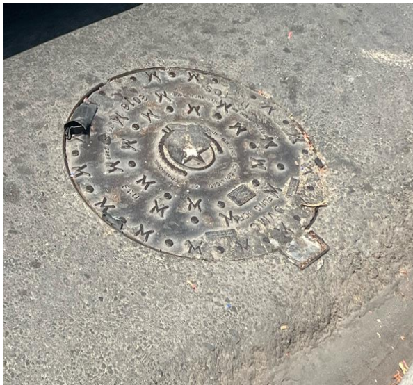
Figura 56. Tapa de Cámara de Inspección A37
