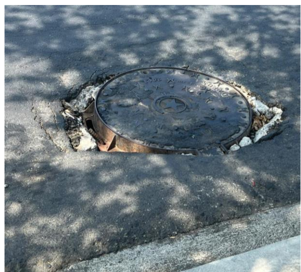
Figura 23. Tapa de Cámara de Inspección A4
