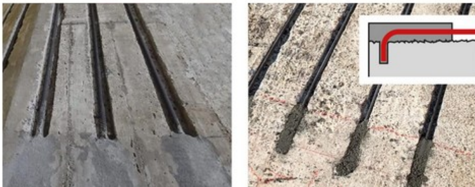
Figura 2.22a Ranura para fijación, centrado y anclaje de barras Fe-SMA. (Re-fer.eu, 2025)
