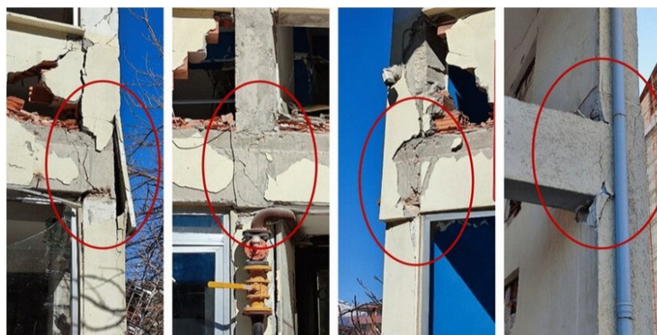
Figura 2.3 Daño en nudos, terremoto de Turquía, región de Hatay, 2023 (Doğan et al., 2024)
