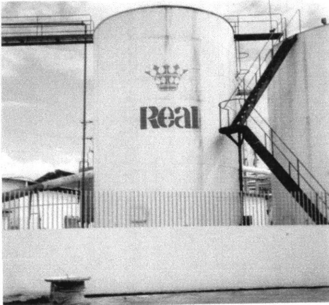
Figura # 7.- Tanque de almacenamiento de diesel (71.000 gls.)
