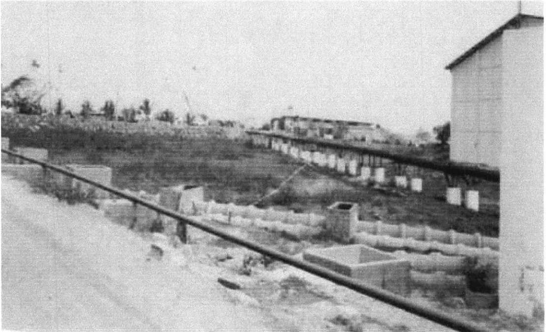
Figura # 15.- Actual oleoducto de bombeo desde planta al muelle
