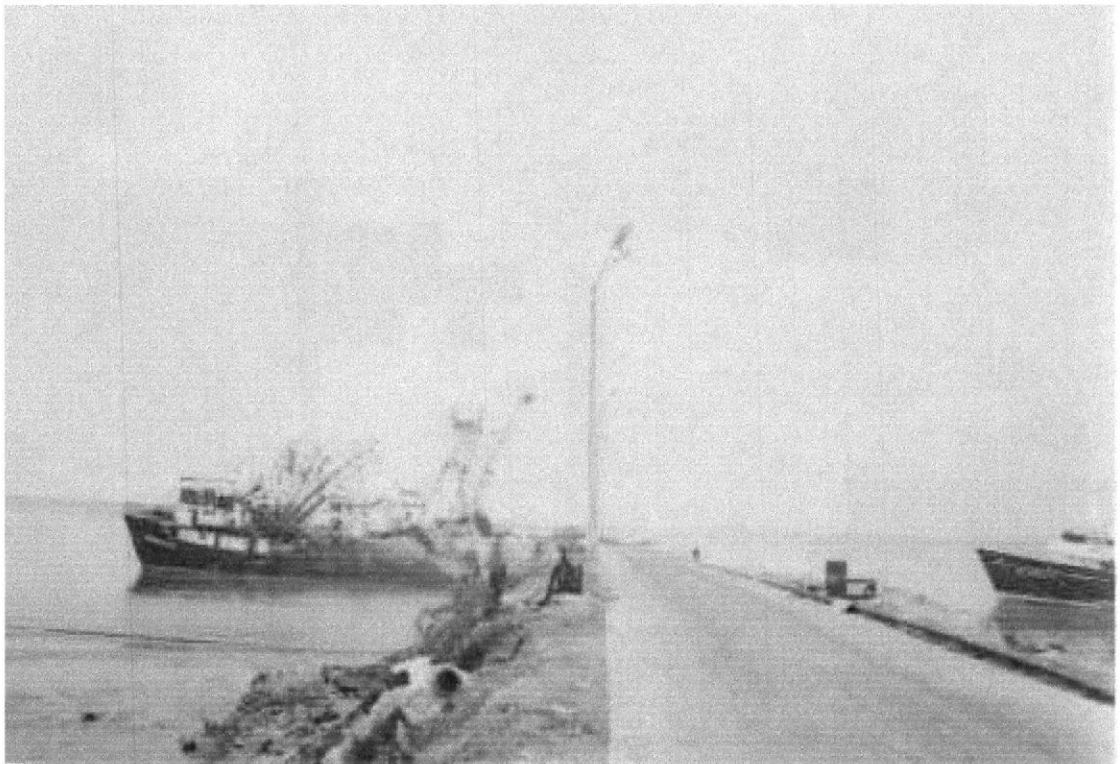
Figura # 16.- Actual línea de bombeo de combustible en el muelle
