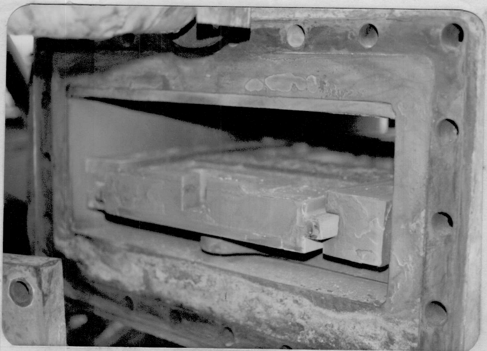
Vista interna de la bajante de catalizador regenerado en donde se encuentra la respectiva válvula deslizante.
