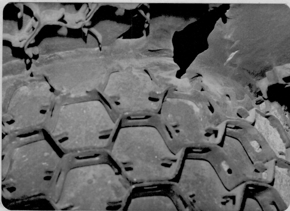
Parte interna de la cámara de un ciclón primario del regenerador. (nótese las perforaciones y caída de malla)
