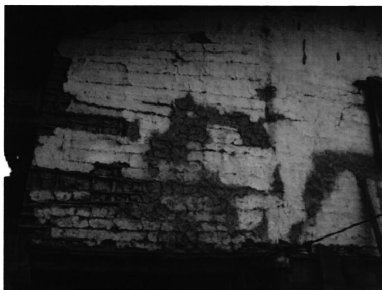
Figura 46. Pared de vivienda, San Pedro de Güizhagüñay, cantón Zaruma.
