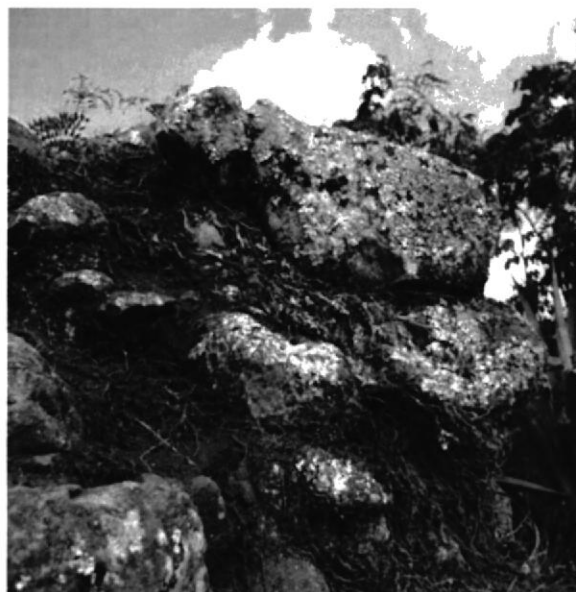
Figura 51. Detalle de muro en el sitio cacique Duma Obsérvese la arcilla abundante y las rocas de campo utilizadas (Foto de la autora 2009)
