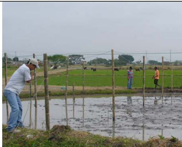
Foto 1. Azollario en construcción
