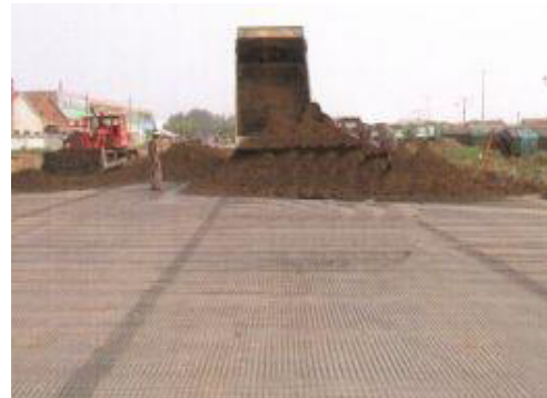
b) Refuerzo de Sub-rasantes
