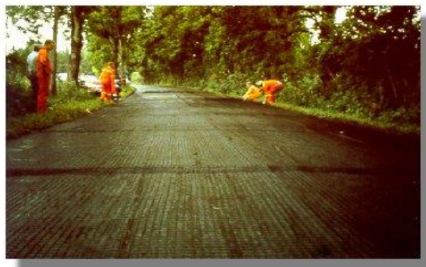
c) Refuerzo de capas de rodadura
