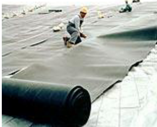
Figura 1.4 Geomembrana
