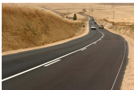
Figura 2.3 Capa de Rodadura
