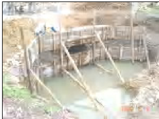
Figura 3.20 Colocación de Encofrados en Muros de Alas
