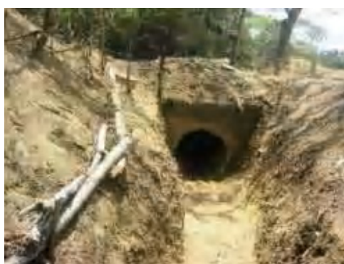
Figura 4.4 Alcantarilla luego de la limpieza
