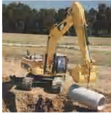
Figura 3.6 Izado de Tubería
