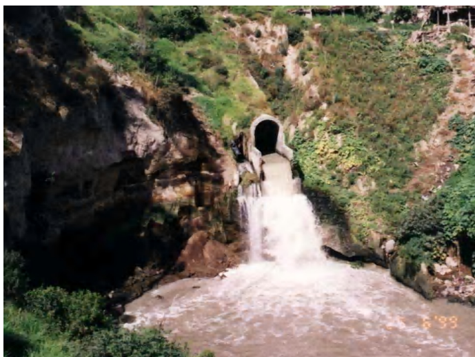
Figura 1.12 Disipador de energía
