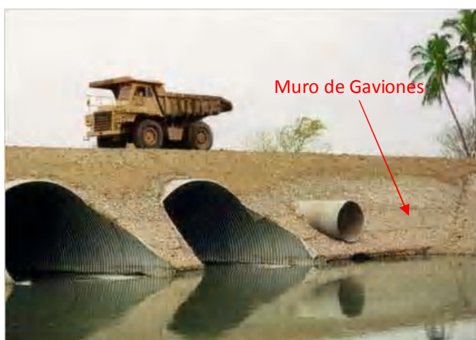
Figura 1.9 Muro de Gaviones
