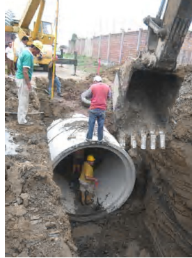
Figura 3.8 Colocación de tubería
