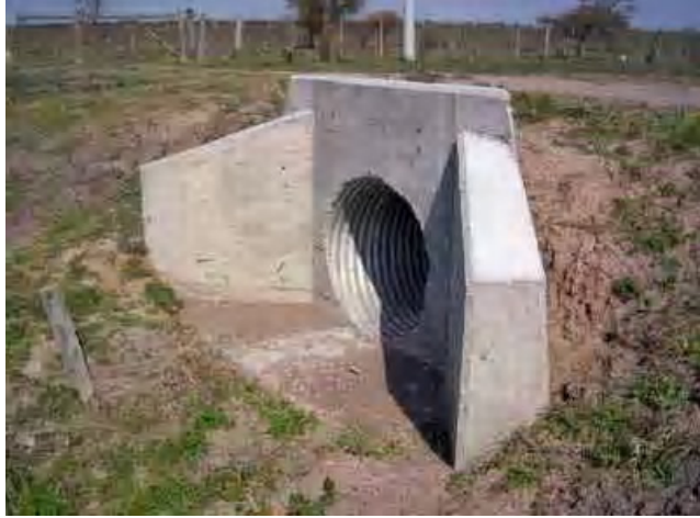
Figura 1.6 Muro de Alas
