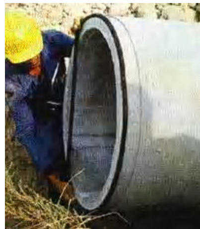
Figura 3.11 Instalación de juntas de neopreno
