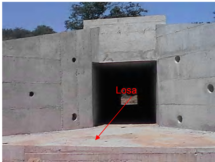
Figura 1.8 Losa de Hormigón
