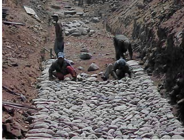
Figura 1.11 Muro de Escollera
