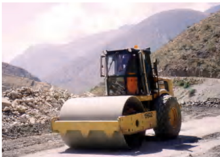
Figura 3.19 Rodillo compactando Capa a Nivel de Subrasante
