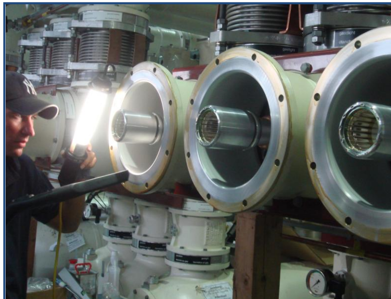
Fig 17. Limpieza del blindaje trifásico de barras
