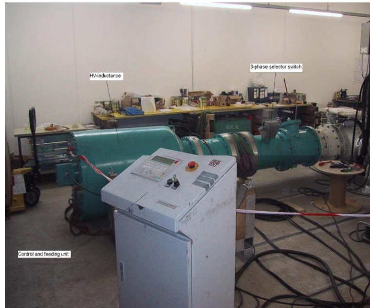
Fig 25. Equipo para prueba de Alta Tensión
