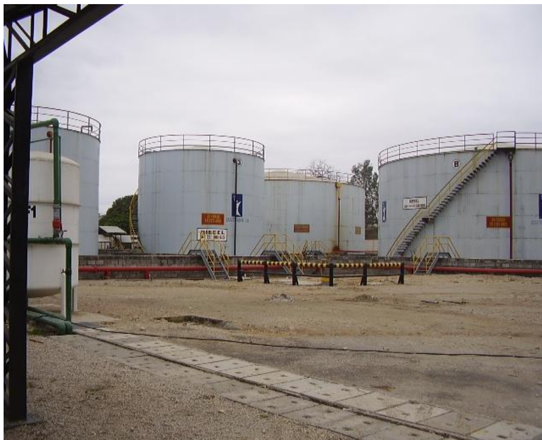
FIGURA G.3 TANQUES DE ALMACENAMIENTO DE COMBUSTIBLE
