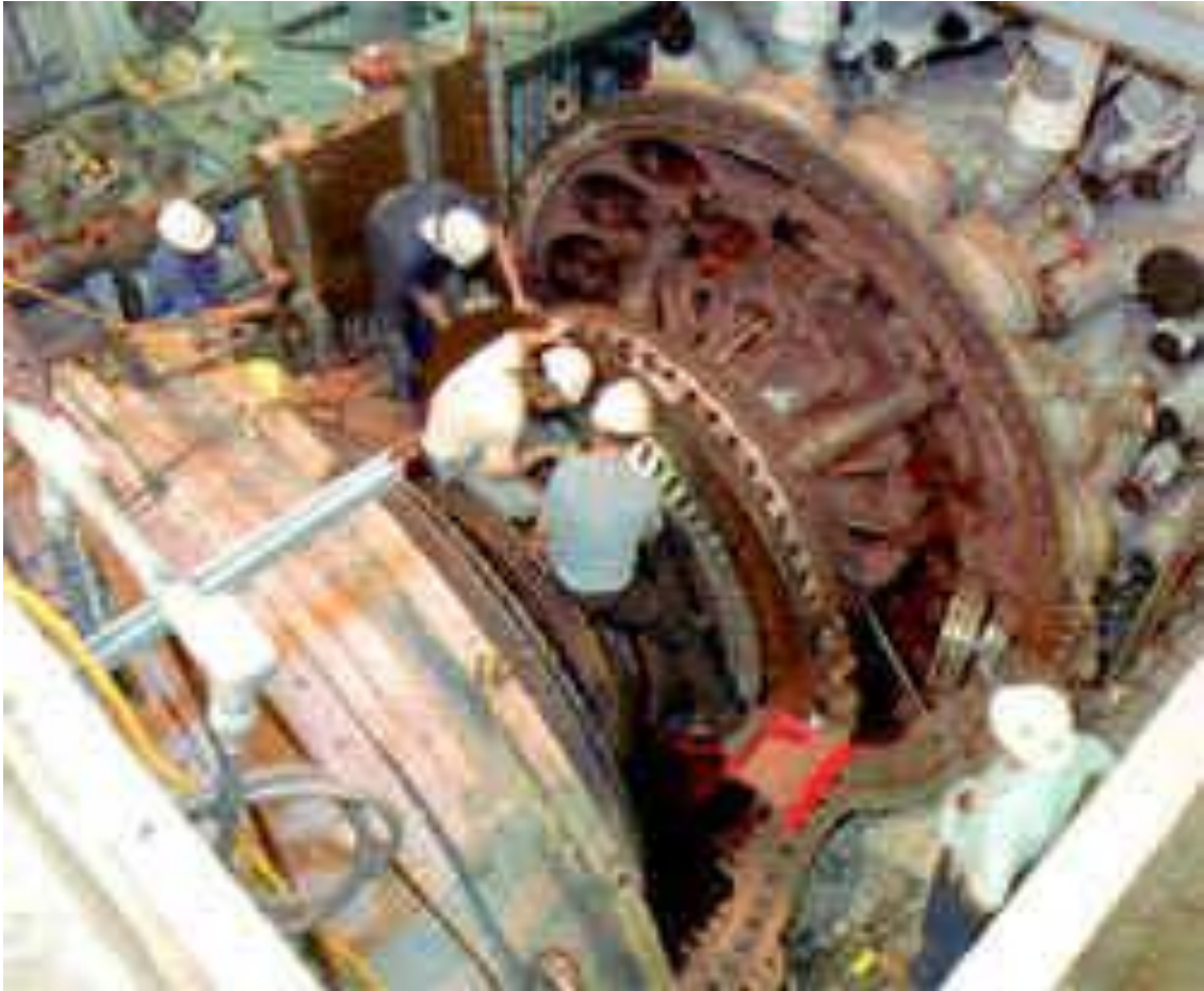
FIG.7.1. MANTENIMIENTO DE UNA TURBINA DE TIPO INDUSTRIAL
