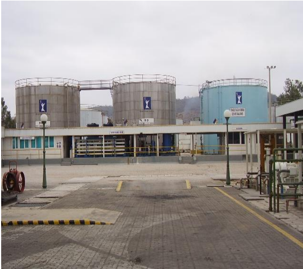
FIGURA G.1 TANQUES DE ALMACENAMIENTO DE AGUA
