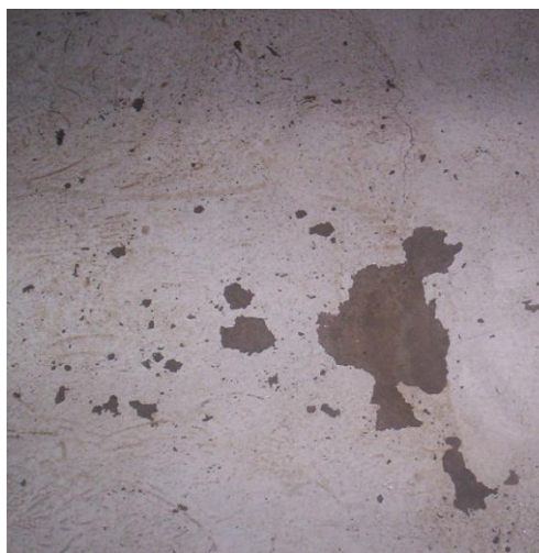
Figura 3.1 Piso de la planta con presencia de grietas
