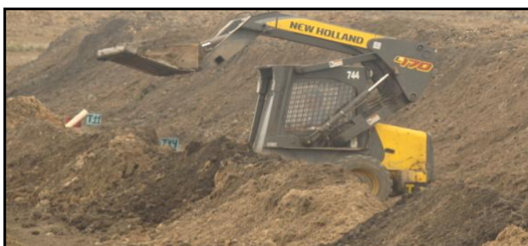
FIGURA 2.3: Volteo de Pilas
