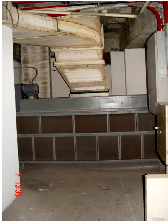
Figura 1.4. MANEJADORA DE AIRE
