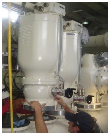
Fig. 11. Transformador de Potencial
