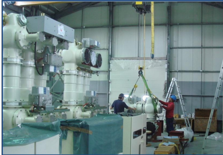
Fig 15. Proceso de montaje.
