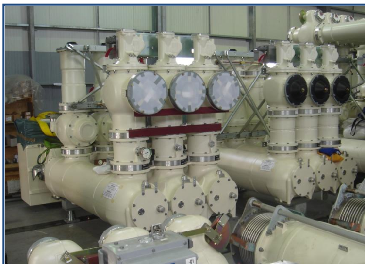
Fig 14. Módulo de bahía colocada en sitio de montaje
