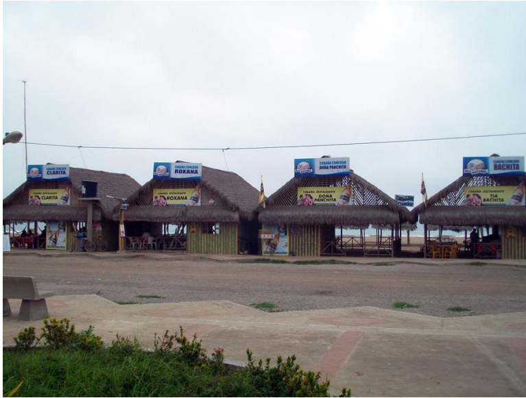
Infraestructura Turística, San Pedro
