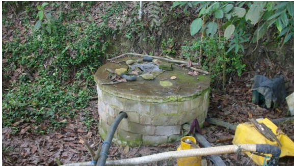
Captación de agua de pozo profundo para agricultura, Loma Alta
