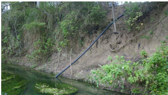
Captación de agua desde el río Valdivia-California para agricultura, Loma Alta
