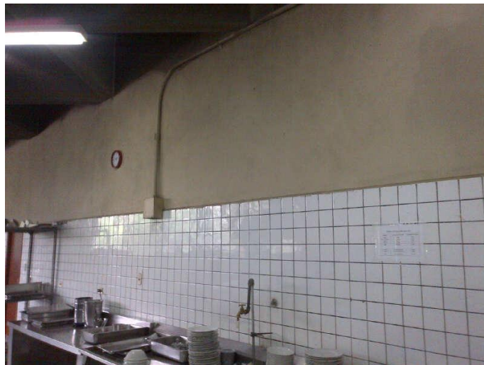
FIGURA 4.3 PAREDES EN ÁREA DE ELABORACIÓN
