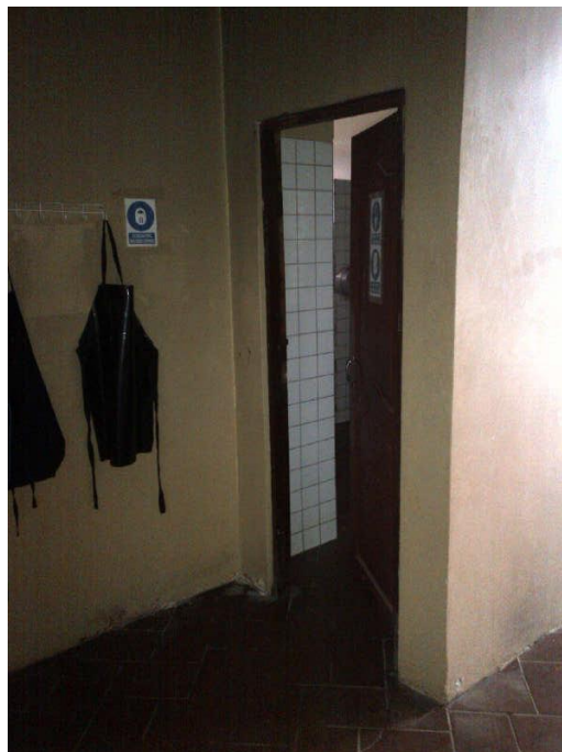
FIGURA 4.14 INGRESO INSTALACIÓN SANITARIA
