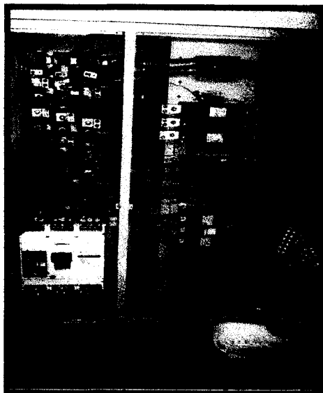
FIG 4.2 Panel de distribución del centro de carga # 1 (501 KVA)
