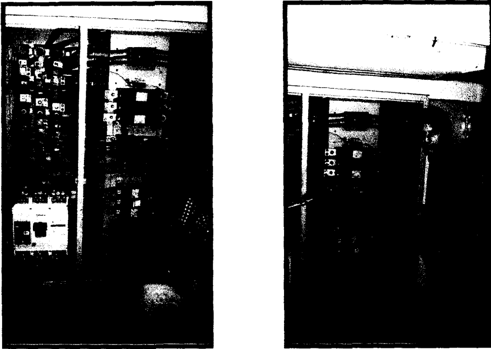
FIG 3.2 Panel de Distribución Principal (Banco de Transformadores 501 KVA) ubicado en el sótano del edificio de Química
