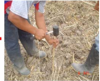
Colocación de estacas
