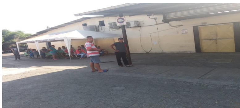
Figura 33 Área de emergencia del hospital básico del Carmen
