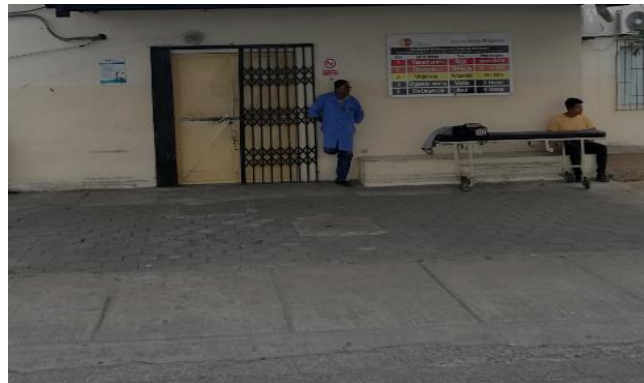
Figura 52 Área de atención de emergencia del hospital básico del Carmen
