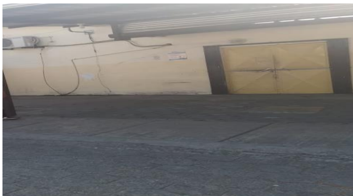
Figura 43 Sala del área de emergencia
