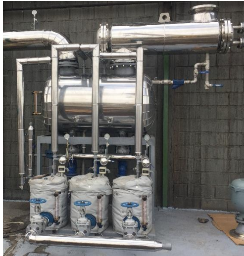
Figura 7. Sistema de recuperación eficiente de condensados
