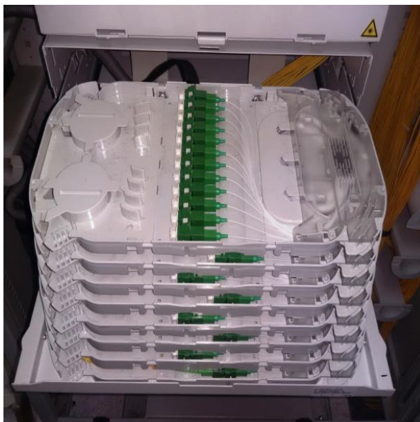
Figura 3.11: Bandejas de un ODF
