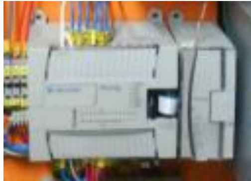
Figura 5.62: PLC Micrologix 1200 y Modulo de Expansor Analógico.
